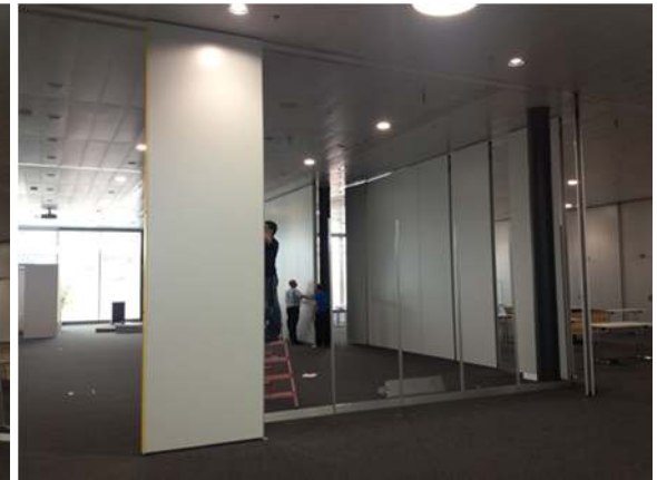
Esempio pareti modulari a Swisstech, Lausanne (2015)
